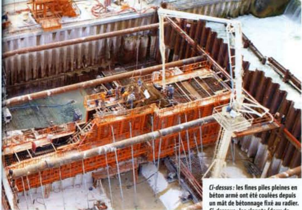
Ci-dessus: les fines piles pleines en béton armé ont été coulées depuis un mât de bétonnage fixé au radier. Ci-dessous: les clapets (deux de 110 tonnes, un de 44 tonnes) pivotent autour de charnières encastrées dans le radier.
